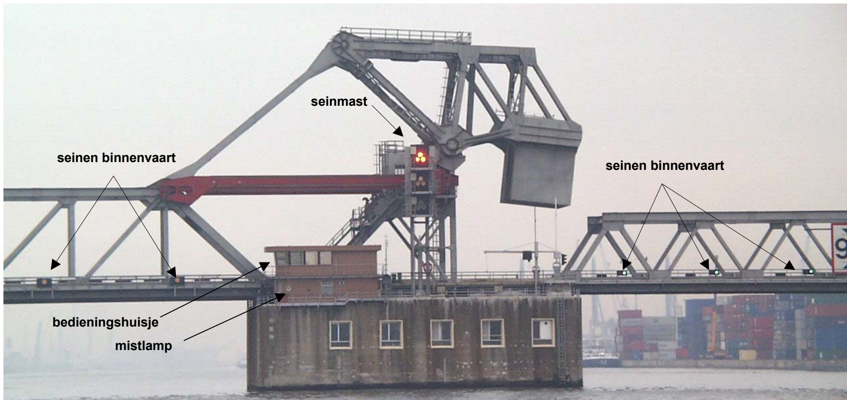
Figuur 1.3 - Lillobruggen - zicht vanuit het zuiden - detail van de hoofdpijler oost
